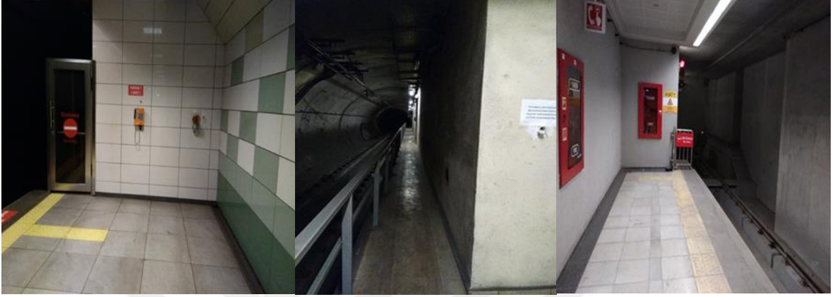
Şekil 3.6: Dedektörlerin istasyon peronlarına konumlandırılmasına örnekler.
