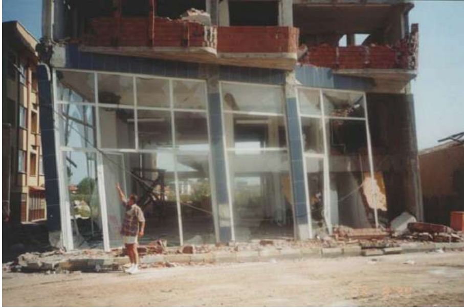
Şekil 4.16. Zayıf kat hasarı (1999 Kocaeli Depremi) (Tezcan, 2007)
