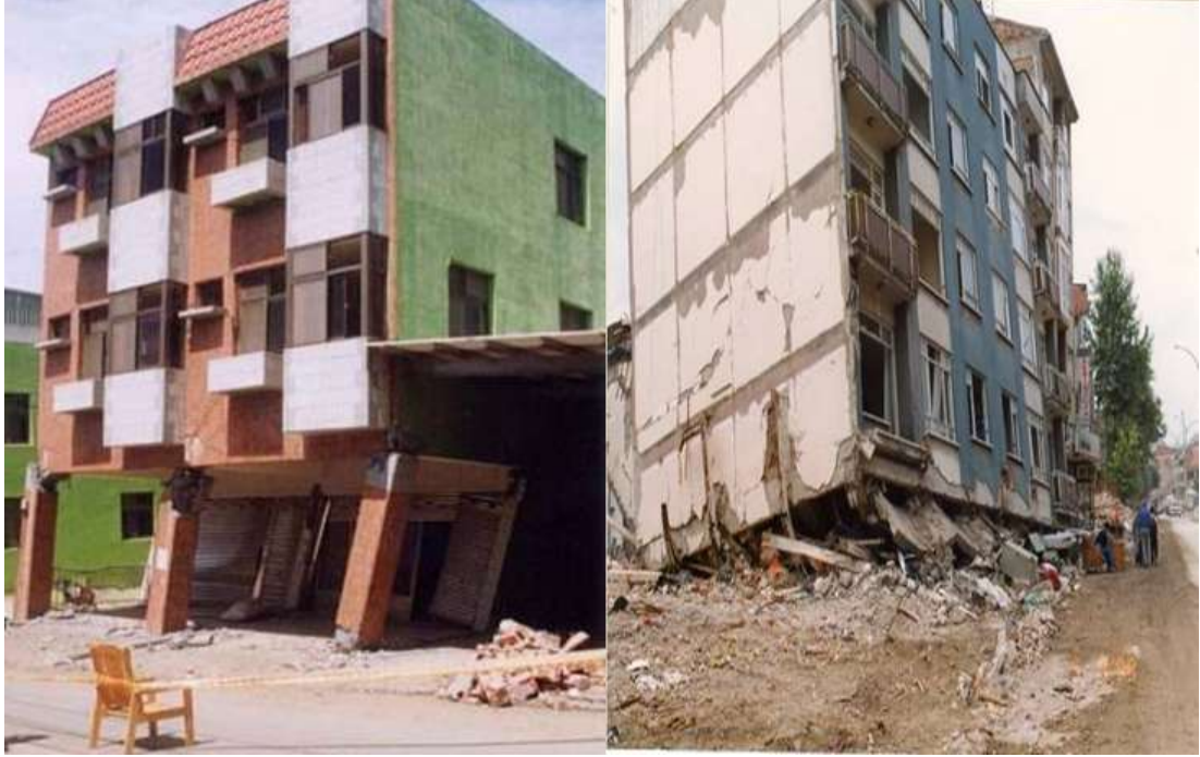
Şekil 4.4. Yumuşak kat etkisi (Topçu, 2007)
