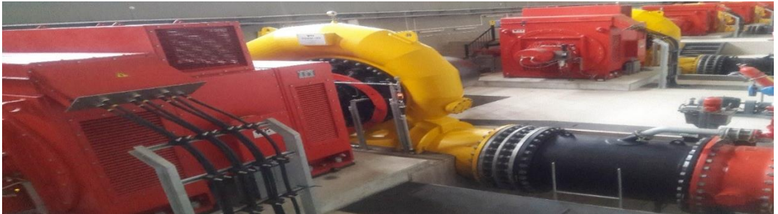
Şekil 2. 11. HES makina dairesi görüntüsü 4
