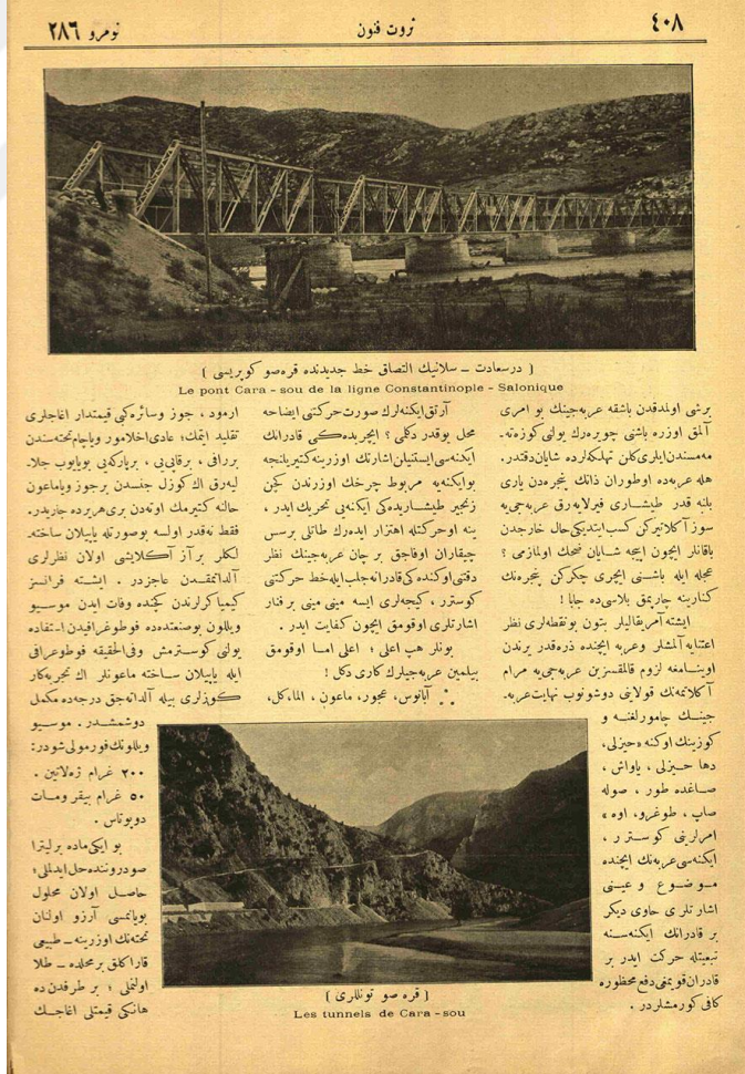
Şekil 59: Dersaadet-Selanik İltisak Hatt-ı Cedidinde Karasu Köprüsü (üstte) ve Tünelleri (altta)
