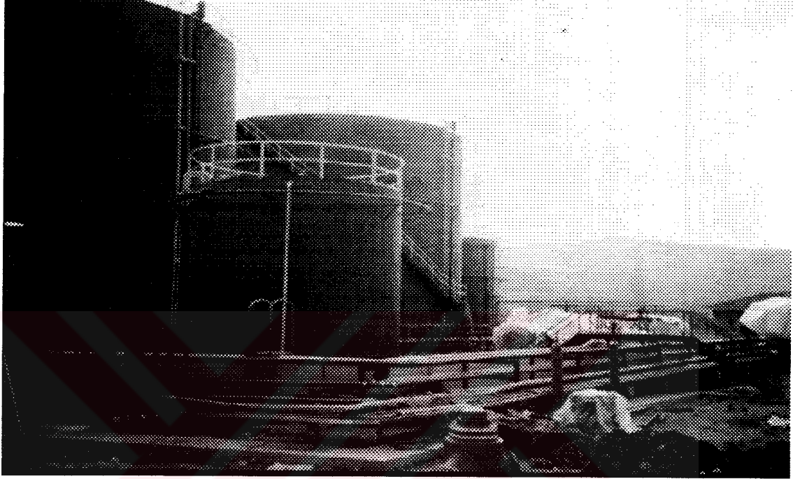
Şekil 3.2. Yakıt ve yağ depolama tankları
