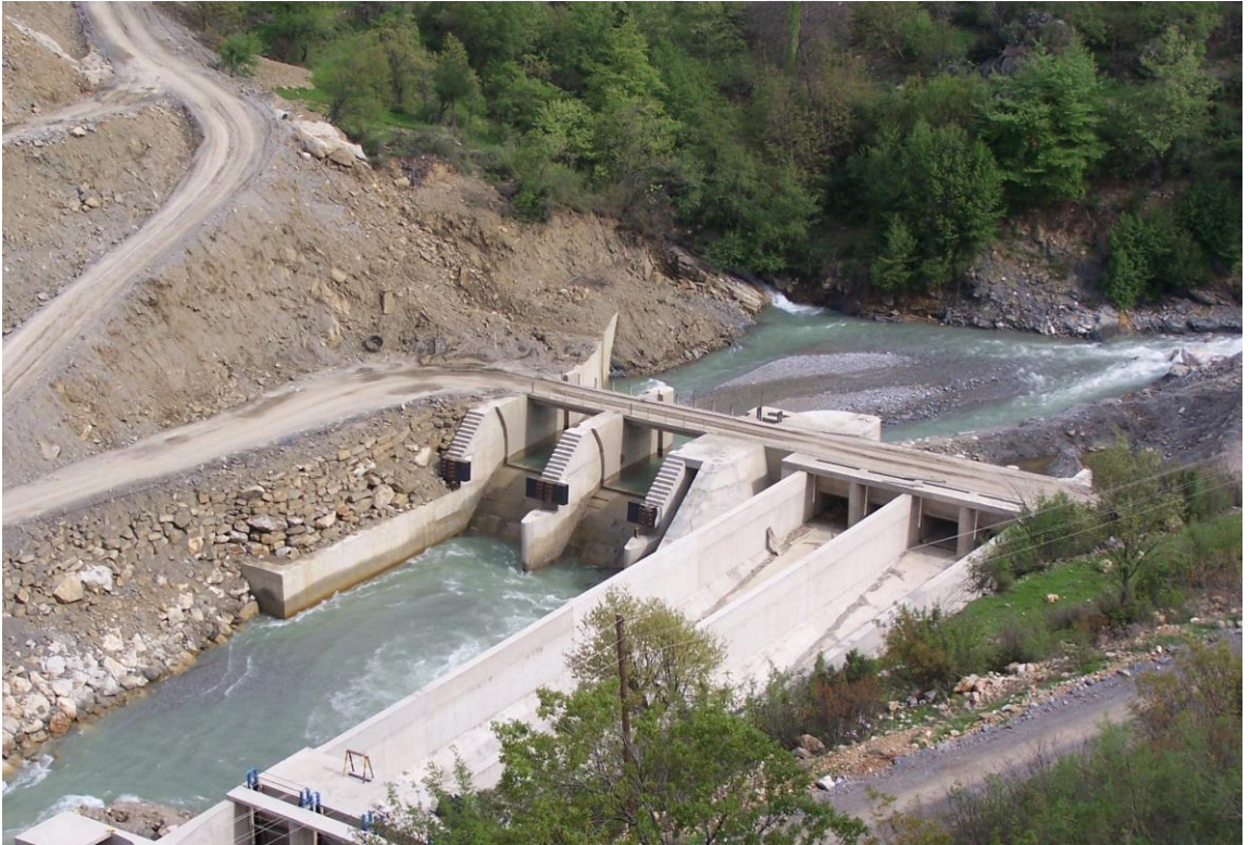
Şekil 4: Nehir Tipi HES'in Su Alma Yapısı (Regülatör)
