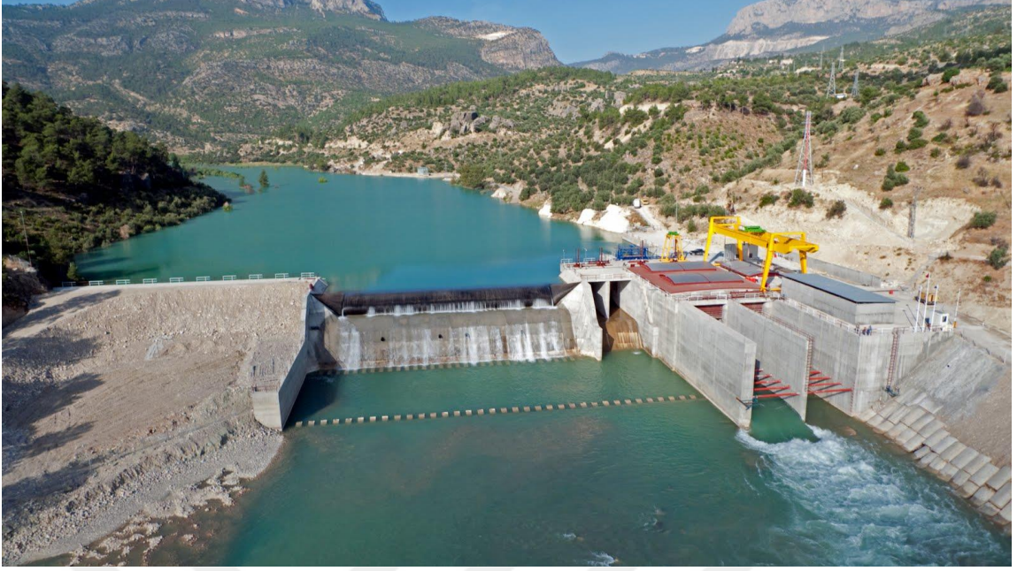
Şekil 3: Nehir Tipi HES (Biriktirmesiz)
