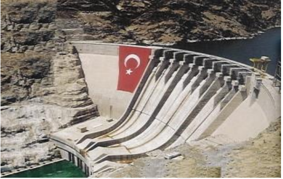
Şekil 7: Beton Ağırlıklı Kemer Baraj ve HES'i (Biriktirmeli)
