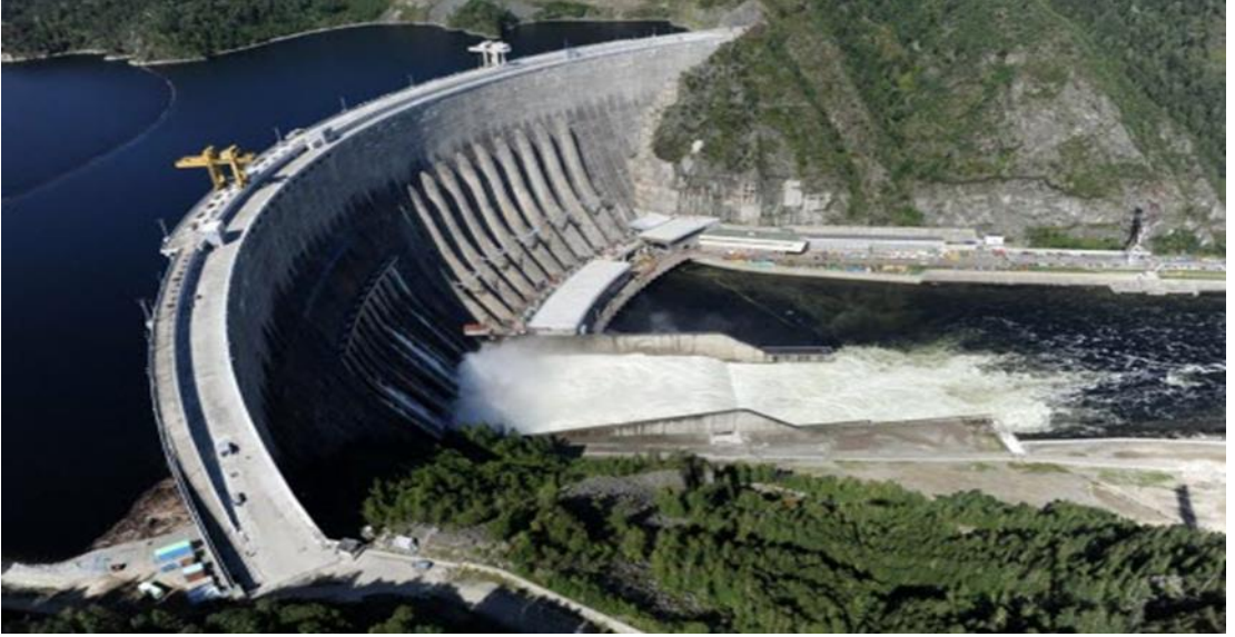
Şekil 2: Beton Kemer Baraj ve HES'i(Biriktirmeli)
