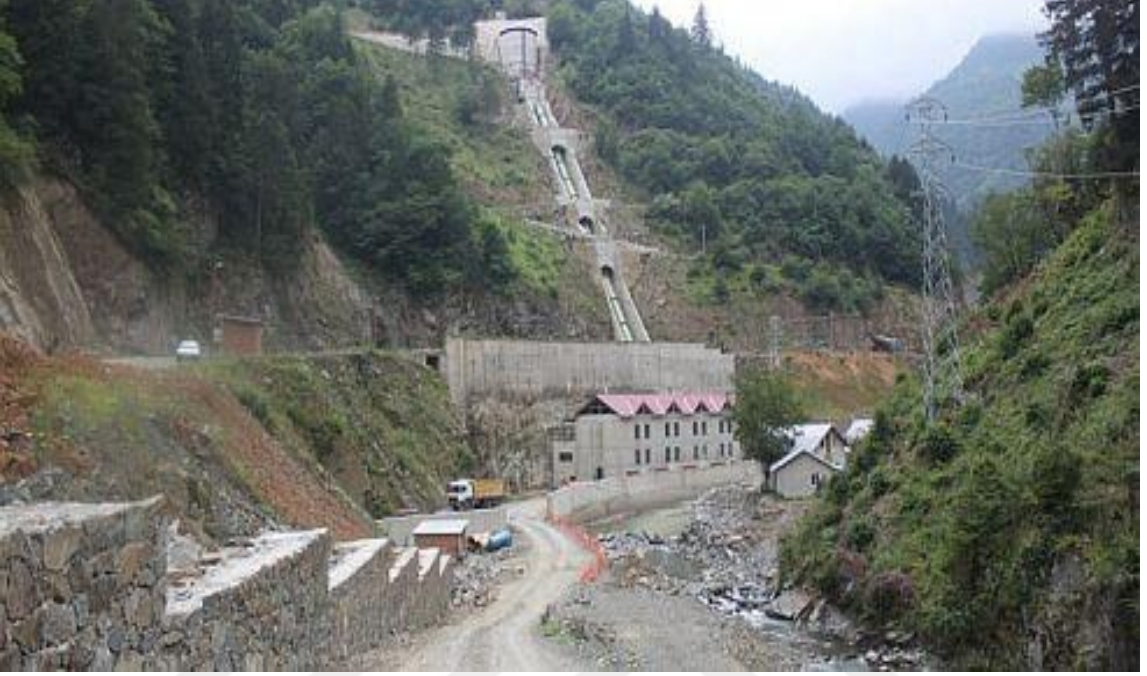
Şekil 1: Nehir Tipi HES, Santral ve Cebri Boru (Biriktirmesiz)
