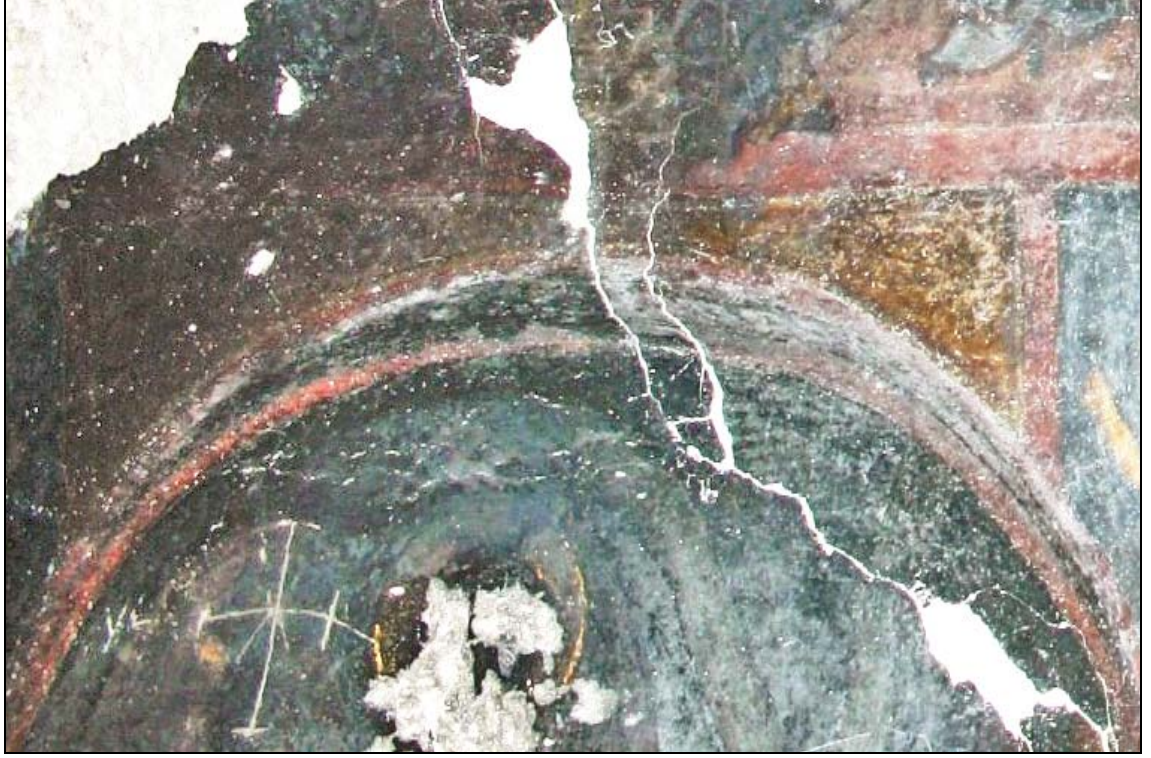
Resim 136: Archangelios Kilisesi; kuzey ve güney nefleri ayıran payede, narteks kısmında yer alan niş kemerli yüzeyi, kıvrık dallar
