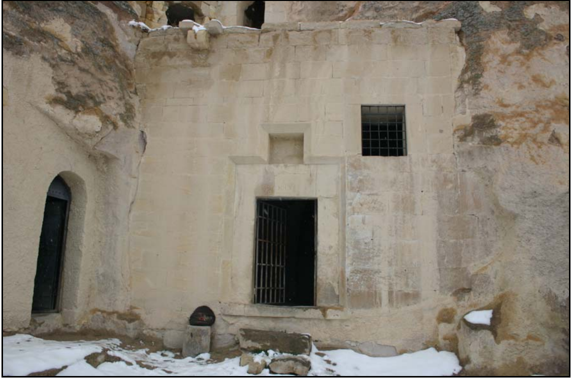
Resim 74: Archangelios Kilisesi; giriş kapısı
