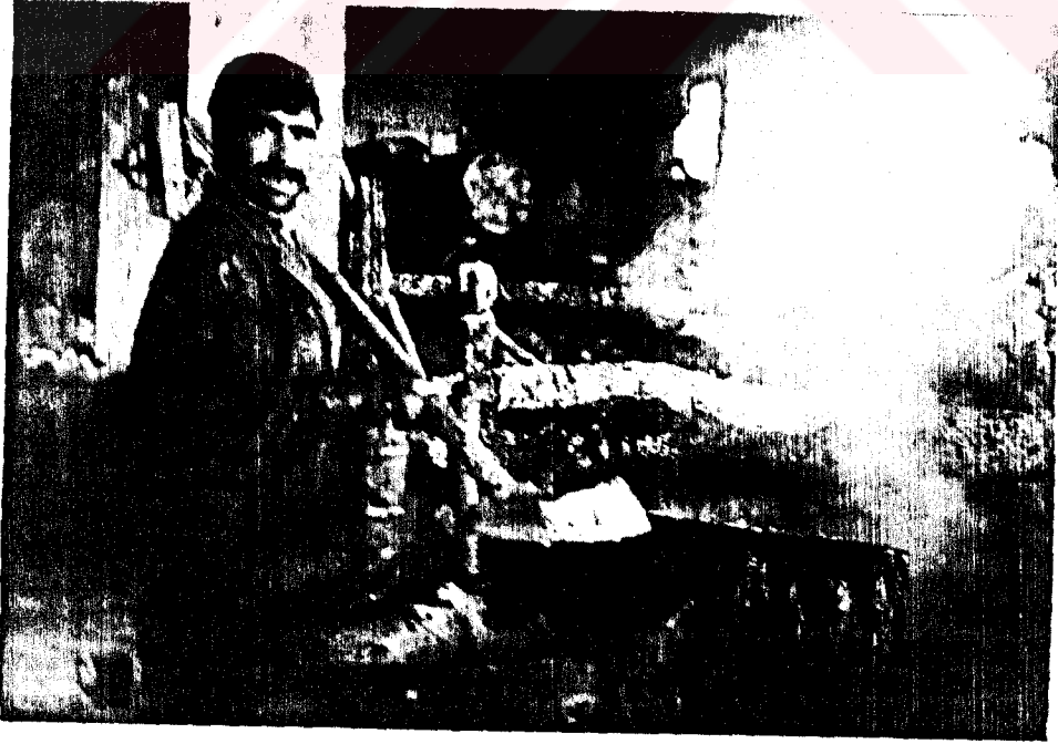
Resim-13. Sabun yapımında kullanılan yağların eritildiği kazan
