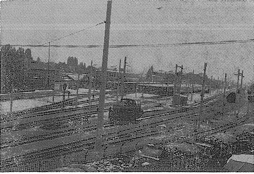
FOTO 16 : Demiryolu bağlantı hatları ve arka planda gar binası ile demiryolu tesisleri.
