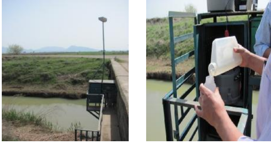
Şekil 3.11. Havza çıkışındaki drenaj kanalı üzerine tesis edilen AGİ (L4)' te bulunan ve otomatik örnekleyiciden drenaj su örneklerinin alınımı
