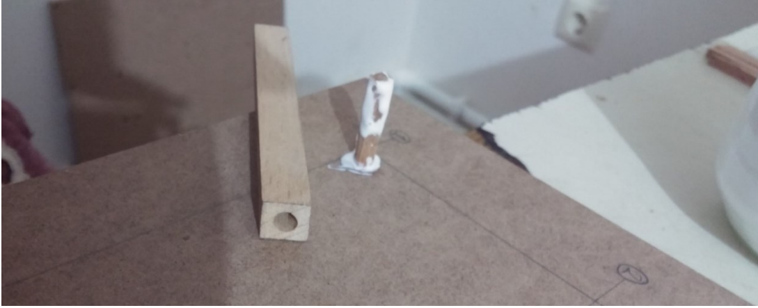
Şekil 2.3. Kolonların delinmesi ve filizlerin yerleştirilmesi
