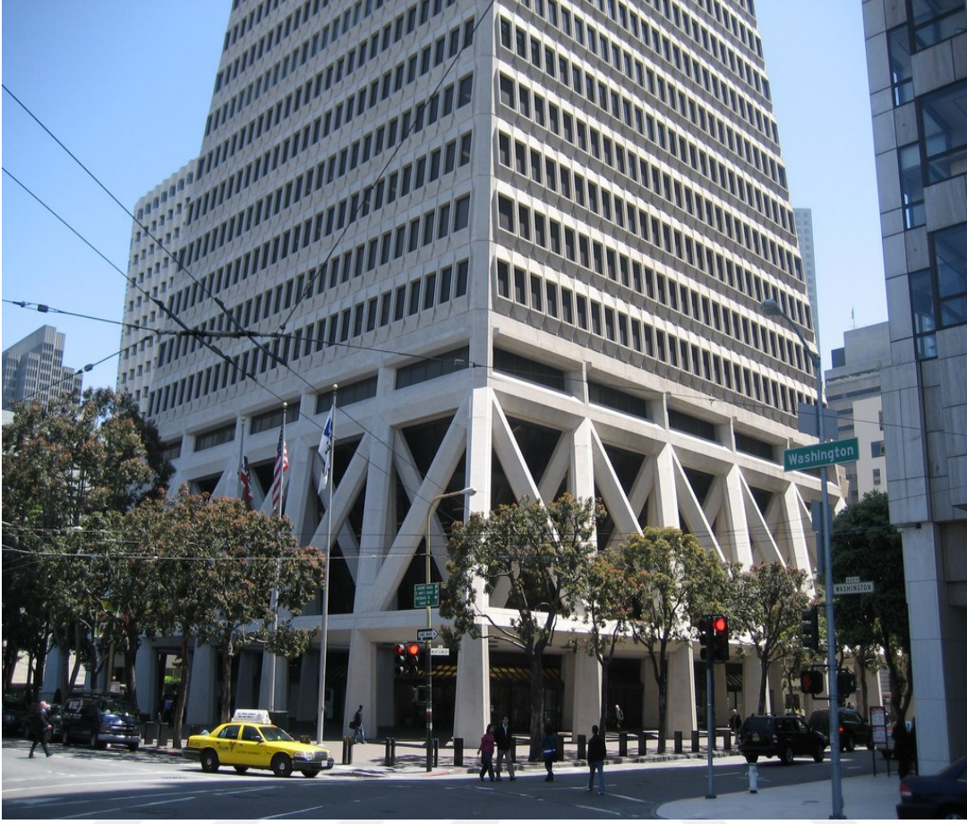
Şekil 1.8. Eğik elemanlara sahip betonarme bir yapı [8].
