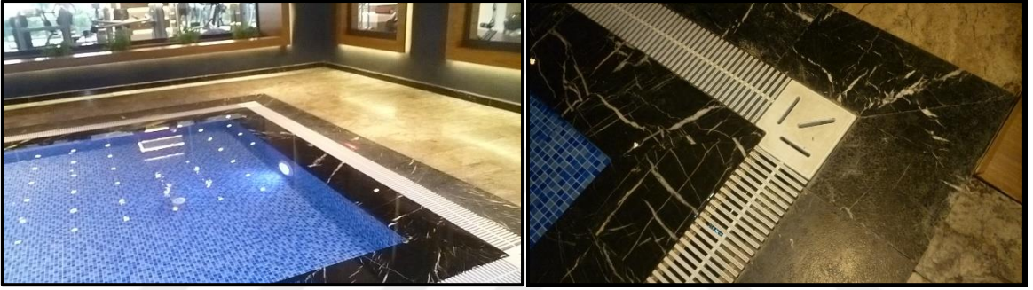
Şekil 68. Havuz bölümü zemin malzeme birleşim detayı ve görselleri
