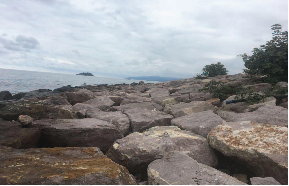
Resim 5 Giresun Espiye arası filtre tabakası uygulama hatası
