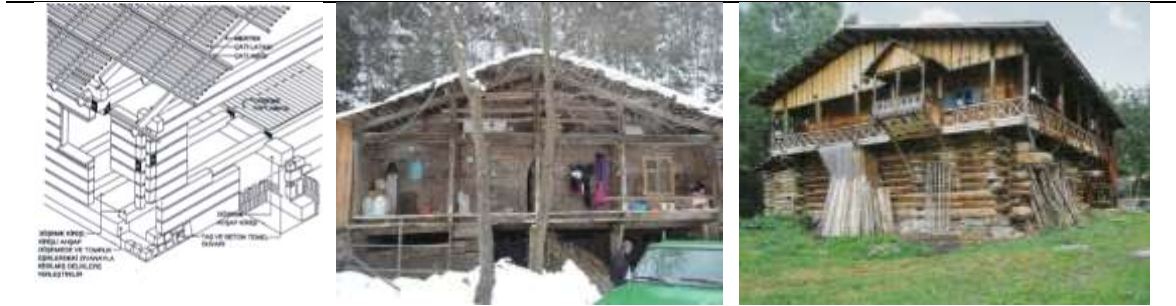
Şekil 7. Ahşap yığma sistemi örnekleri (soldan sağa; Bostancıoğlu ve Düzgün Birer, 2004; Sağsöz, 2000; Batur ve Gür, 2005).
