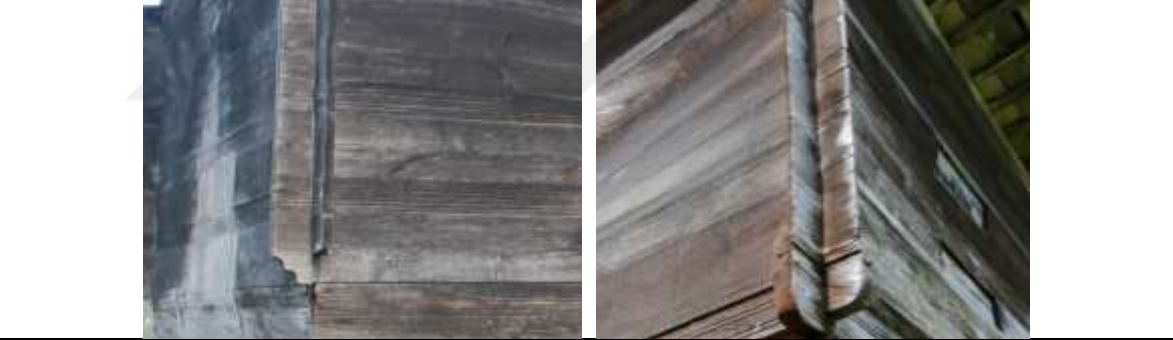
Şekil 26. Geçme tekniğiyle yapılan serender duvar örnekleri (Kukoğlu, 2019).
