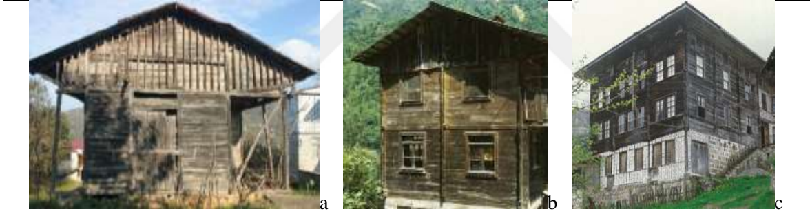
Şekil 9. Ahşap dolma örnekleri, (a) Aksu Köyü, Sürmene, Trabzon (Kukoğlu, 2019), (b, c) Köprübaşı Çamlıhemşin Rize, Yolkiyı, Çamlıhemşin, Rize (Batur ve Gür, 2005).
