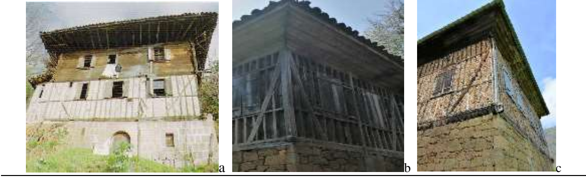
Şekil 8. Ahşap iskeletli (çatma) duvar örnekleri (a) (Sümerkan, 2005), Araklı (b,c) (Kukoğlu, 2019).
