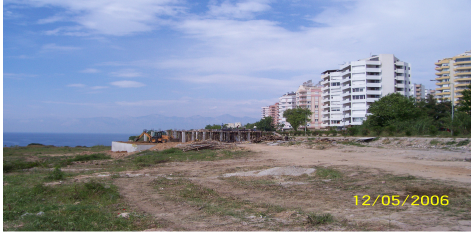
Şekil 17. Falezlerin hemen üzerinde yapımına başlanan restoran inşaatından görünüm
