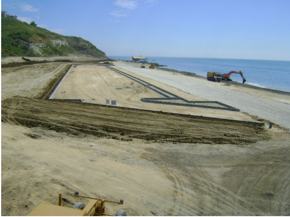
Foto 6. Beylikdüzü (İstanbul) ilçesine bağlı Gürpınar sahilinde ki dolgu çalışmaları ve gerideki falezlerden bir görünüm.(Beylikdüzü Belediyesi Arşivi, 2010)
