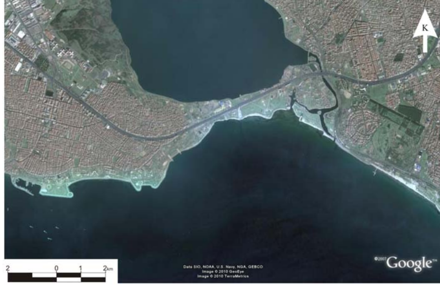
Şekil 7. Küçükçekmece Gölü doğu kıyılarında dolgu ile oluşturulmuş eğlen-dinlen alanı (Google Earth, 2010).
