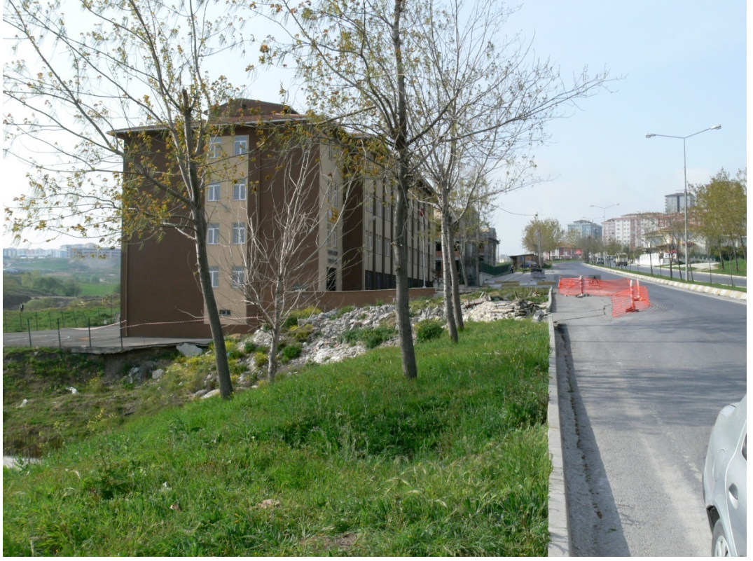
Foto 4. Beylikdüzü (İstanbul) heyelanlı sahasında yeni yapılan ve kayan Yaşar Acar Fen Lisesi, 2010.
