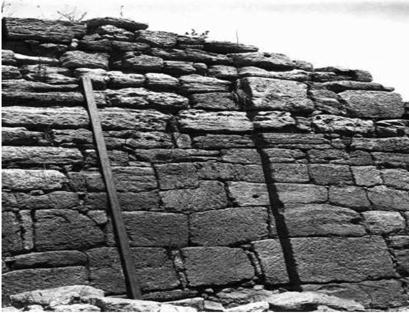
Resim 51 : Troia VI ( Son Tunç Çağı, M.Ö. 15.-13. yüzyıl) Testere dişi tekniğiyle yapılmış kale duvarı. (Dörpfeld Arşivi, DAI Athen 599) (Çevrimiçi)www.troiavakfi.com, 15.02.2012.
