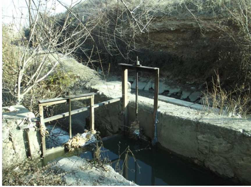
Şekil 3.14. Derme sulamasından sulamaya alınan ilk su alım noktası (Ö.N. 11)
