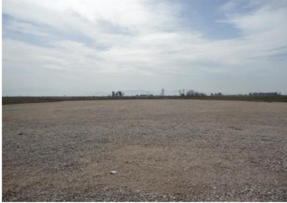
Şekil 4.1. METİP çadır alanı zemin çalışması
