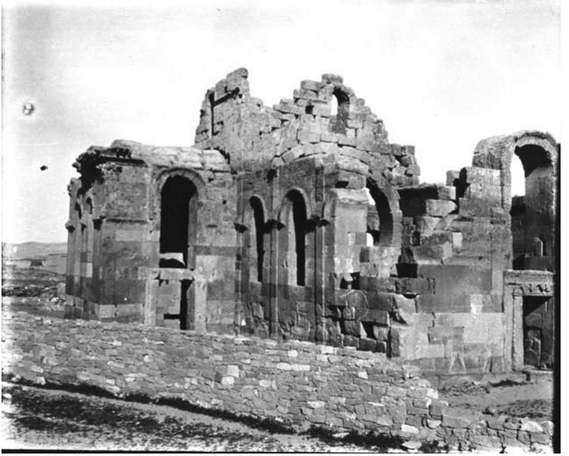
Resim 43. Tomarza Panagia Kilisesi kuzeybatı görünüm (Gertrude Bell'den)
