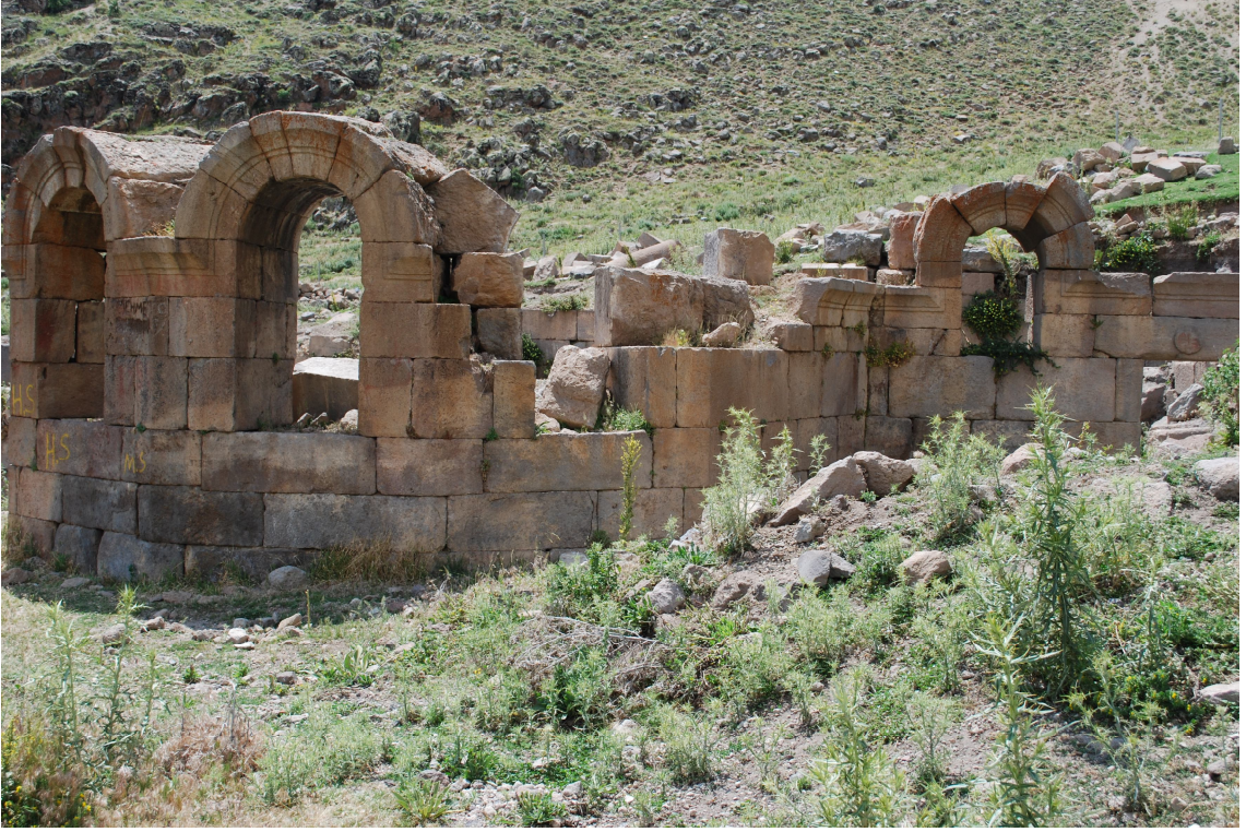
Resim 11. Gereme Panagia Kilisesi kuzey cephe
