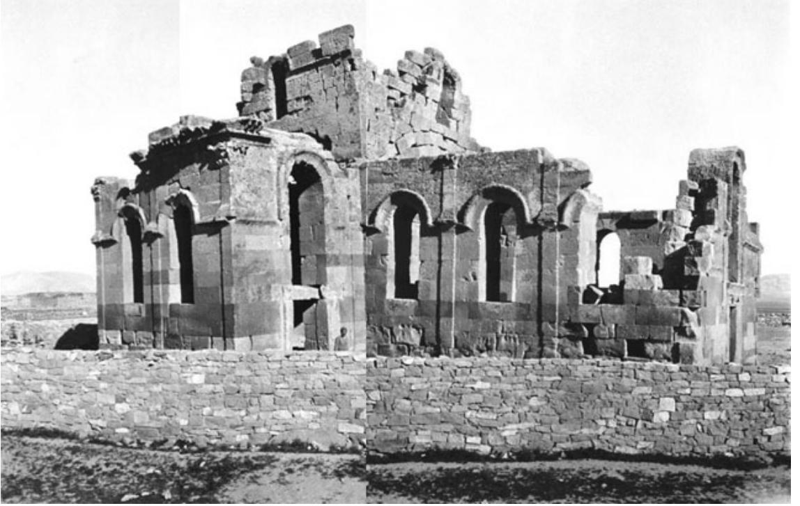
Resim 30. Tomarza Panagia Kilisesi kuzey cephe (Gertrude Bell'den)
