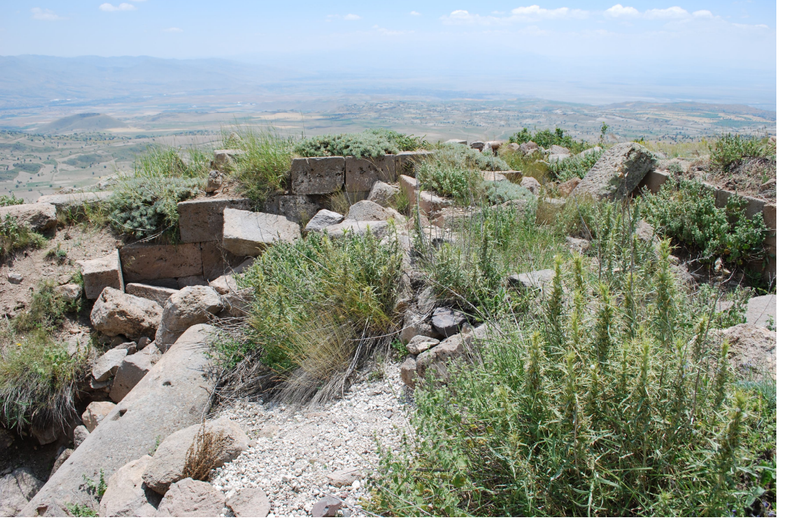
Resim 19. Gereme Dağ Kilise batı duvar
