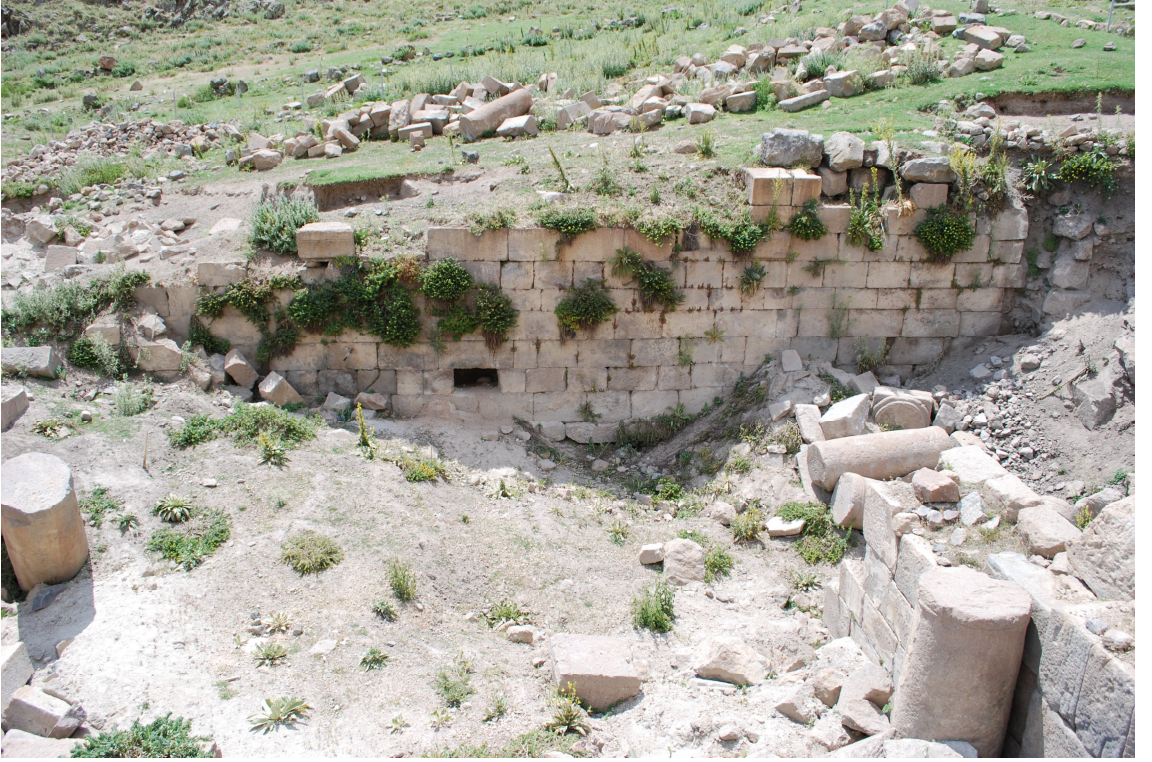
Resim 5. Gereme Panagia Kilisesi batı duvar
