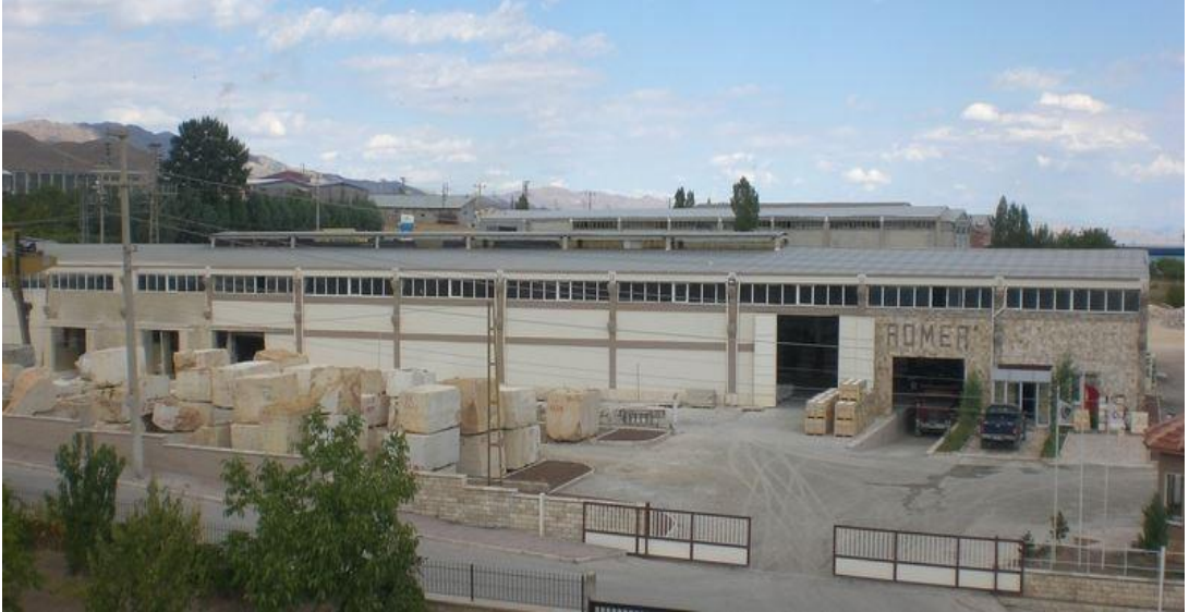
Şekil 3.1. Mermer kesim fabrikasının dıştan görüntüsü
