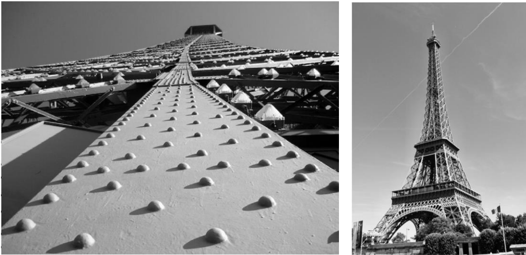
Resim 2.2: Perçin konstrüksiyon – Eiffel kulesi.
