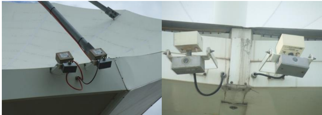
Şekil 3.12: Anten buz çözme ünitesi.
