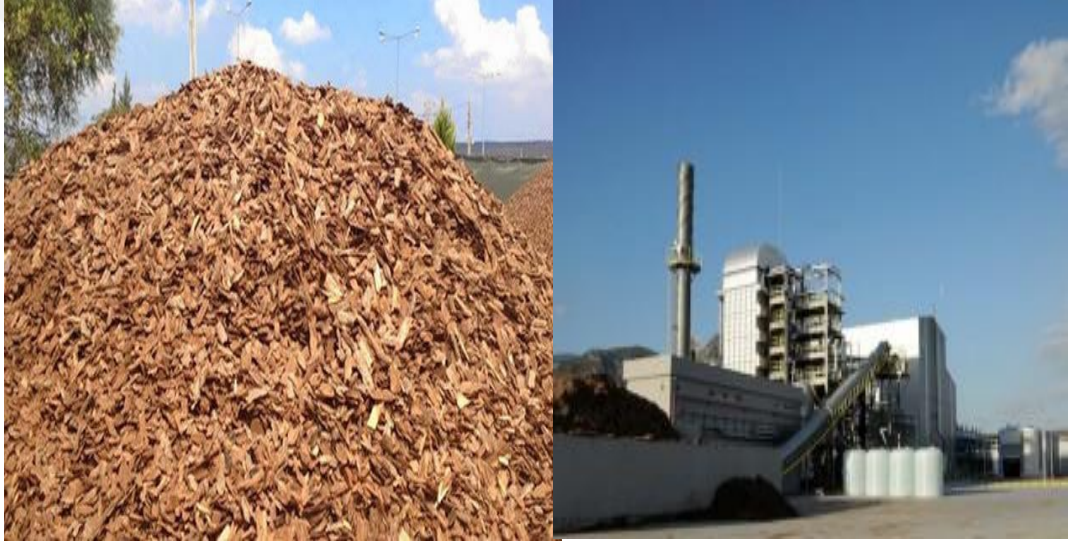
Şekil 5.6 Seka Çaycuma Kağıt Fabrikasında Atık Hale Gelen Biyokütle ve Oyka Biyokütle Enerji Santrali [121]
