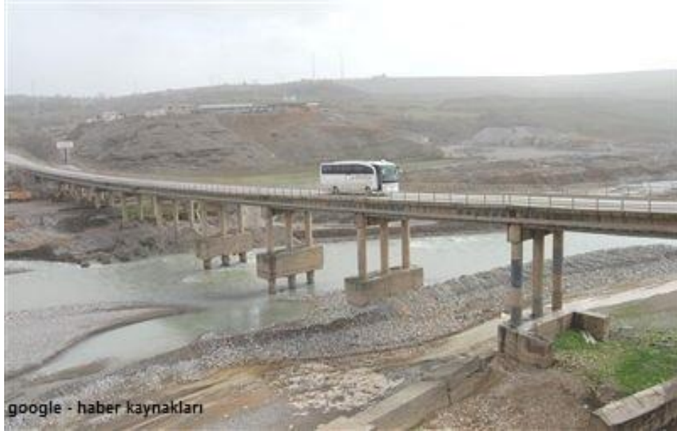
Şekil 1.2. Adıyaman, Göksu köprüsü, ayak oyulması, 2012
