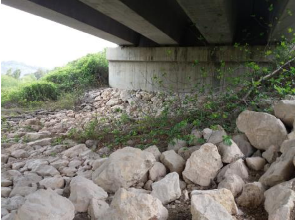
Şekil 4.6. Ceyhan köprüsü kenar ayak taş tahkimat
