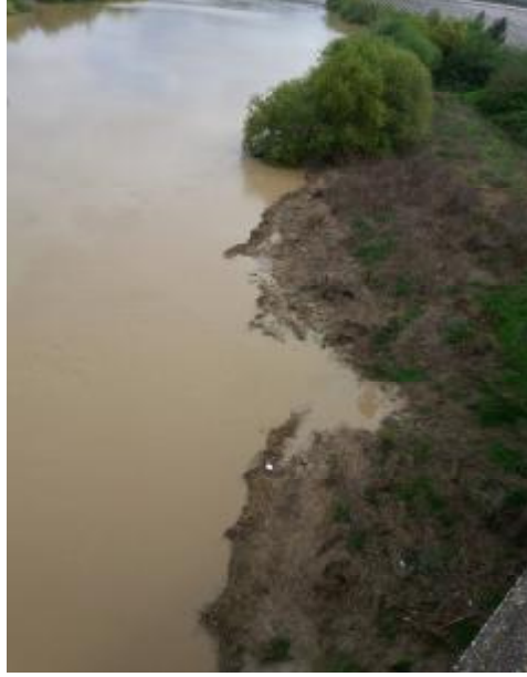
Şekil 3.16. Ceyhan köprüsünün memba kısmına ait zemin görüntüsü
