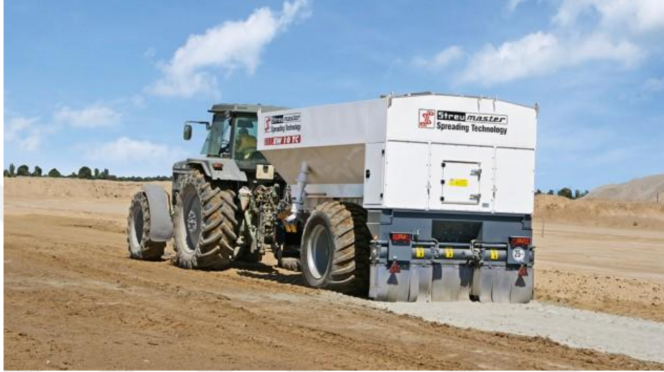
Şekil 2.6. Zemin Stabilizasyonunda Serpme Makinası (Anonim, 2010a)
