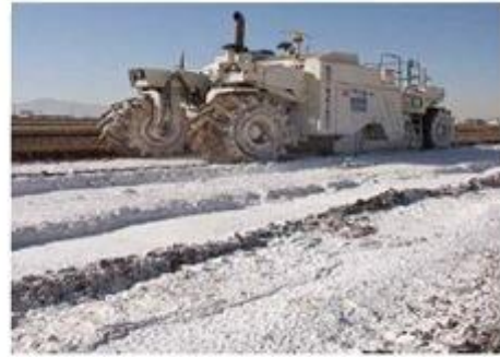
d) Keçi ayaklı silindir ile kirecin zemin ile karıştırılması
