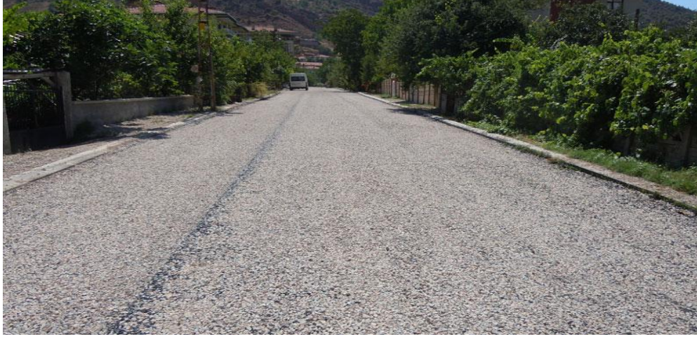
Şekil 2.17. Sathi Kaplamalı Yol Örneği (Anonim, 2018d)
