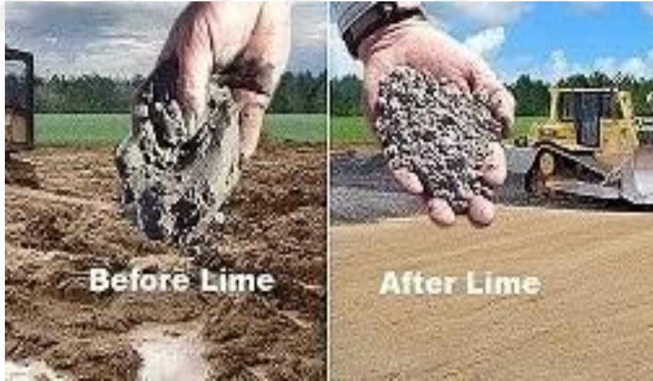
Şekil 1.3. Zeminin Kireçle Stabilizasyonu, Öncesi ve Sonrası (Anonim, 2019d)
