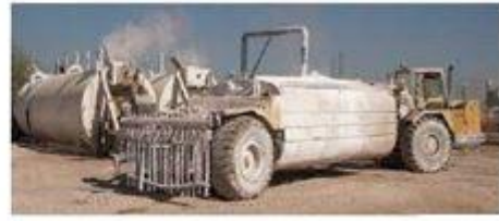
b) Bulamacın dağıtıcıya pompalanması
