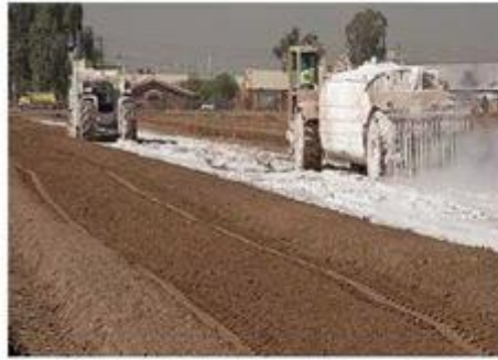
c) Bilgisayar kontrollü dağıtıcının kireci zemin yüzeyine dağıtması
