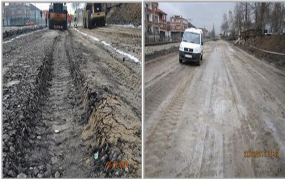
Şekil 1.2. Zemin Stabilizasyonu Öncesi ve Sonrası (Coruk, 2017)
