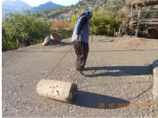
Fotoğraf 26: Yuvak ile toprak dam düzlenirken
