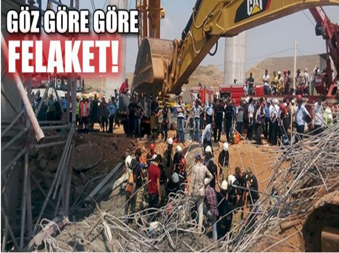
Resim 5b. Viyadük İnşaatında Dört İşçinin Ölmesine Sebep Olan İş Kazası
