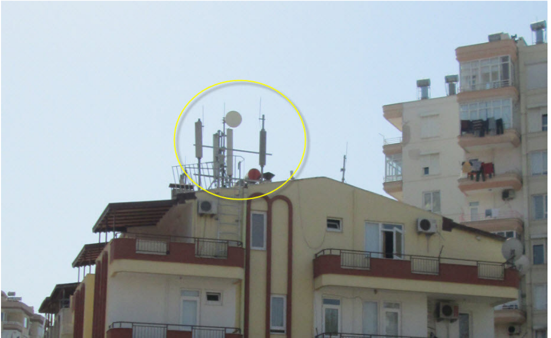
Şekil 2.16 : Makro hücre için çatıya monte edilmiş anten.
