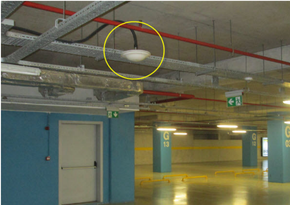
Şekil 2.18 : Piko hücre için otoparka monte edilmiş anten.
