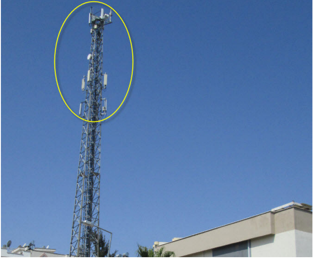
Şekil 2.15 : Makro hücre için kuleye monte edilmiş anten.
