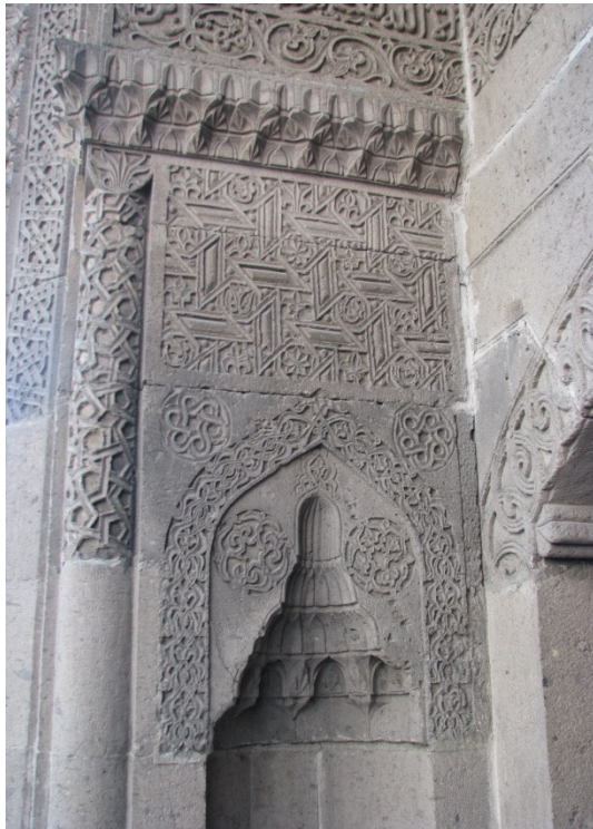
Şekil2.4. Kayseri Hacı Kılıç Camii Yan Duvar süslemeleri
