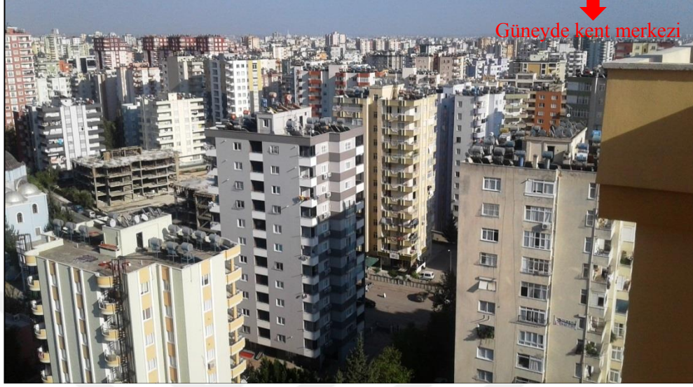
Şekil 6.7. Adana kent merkezinin kuzeye, proje alanına doğru yayılımında yapı yoğunluğu.
