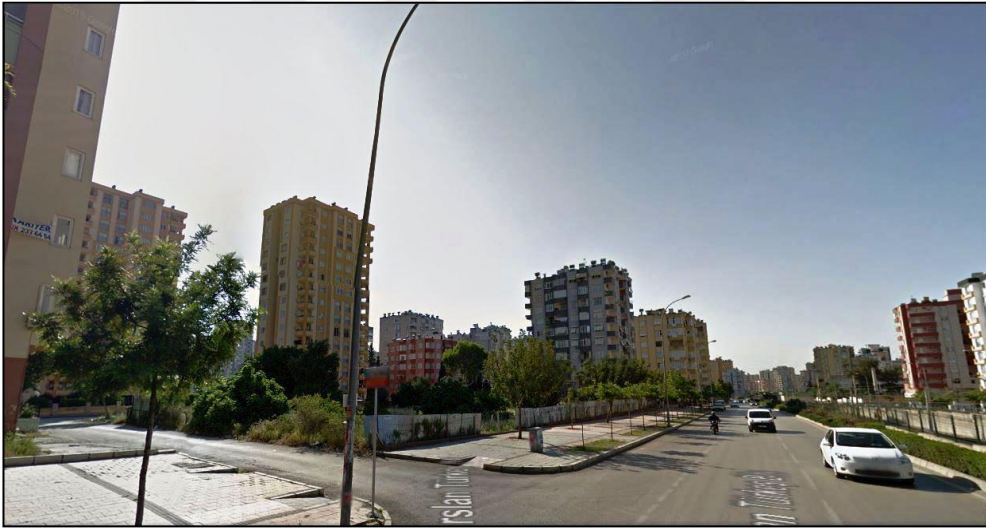
Şekil 6.12. Şekil 6.10'daki 'B' noktasından proje alanı görünüşü.
