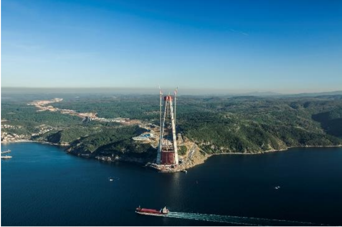
Şekil 1.2 : 3. Boğaz Köprüsü inşaatı ve yakınlarındaki kesilmiş orman arazileri (Kuzey Marmara Otoyolu, n.d).
