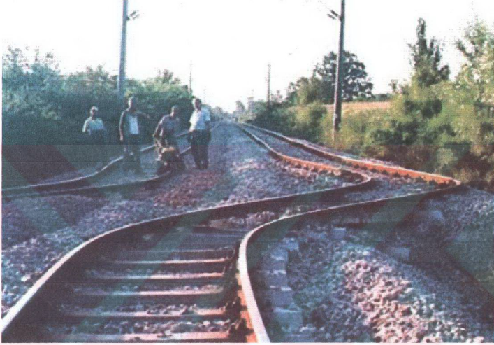
Şekil 3.21 Tepetarla batısında, demiryolunda 300 cm sağ yanal ötelenme ölçülmüştür.
