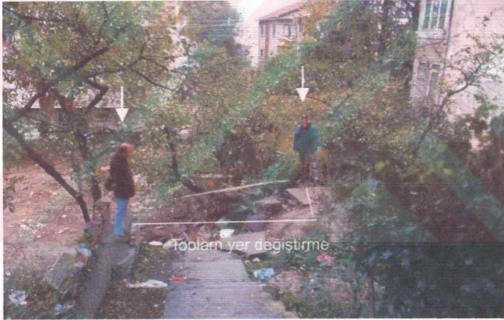
Şekil 3.13 Gölcük civarında, fay tarafından kesilen merdivenler 4,5 m ye yakın ötelenmiştir.
