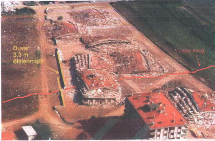
Şekil 3.18 Kullar batısında bir site duvarından 330 cm'lik bir sağ yanal ötelenme ölçülmüştür (Barka vd. 2000).
