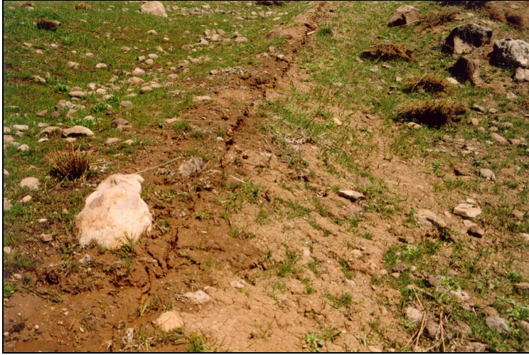
Şekil 7.13. Depremde meydana gelen gerilme çatlakları.
