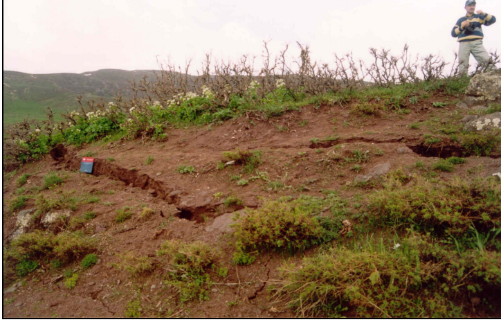
Şekil 7.10. Göltepe Köyü kuzeyinde gelişen heyelan sonucu meydana gelen deformasyon.
