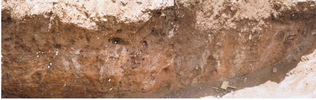
Şekil 4.26 Demirkazık Hendek-1'in güney duvarının ilk 5 m'lik bölümünün görünümü
