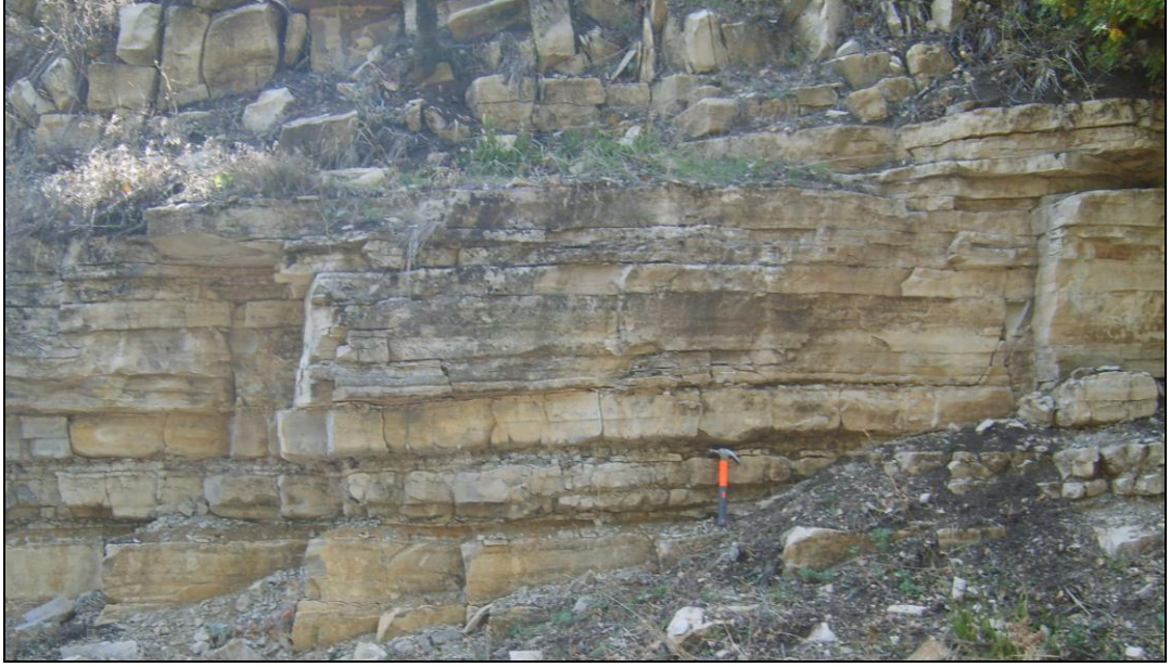
Şekil 5.39: Dürdane Formasyonu içerisinde mercek şeklinde yer alan killi kireçtaşlarının genel görünümü (Kayacıkçayırı tepe, GPS: 0698979-4471616).
