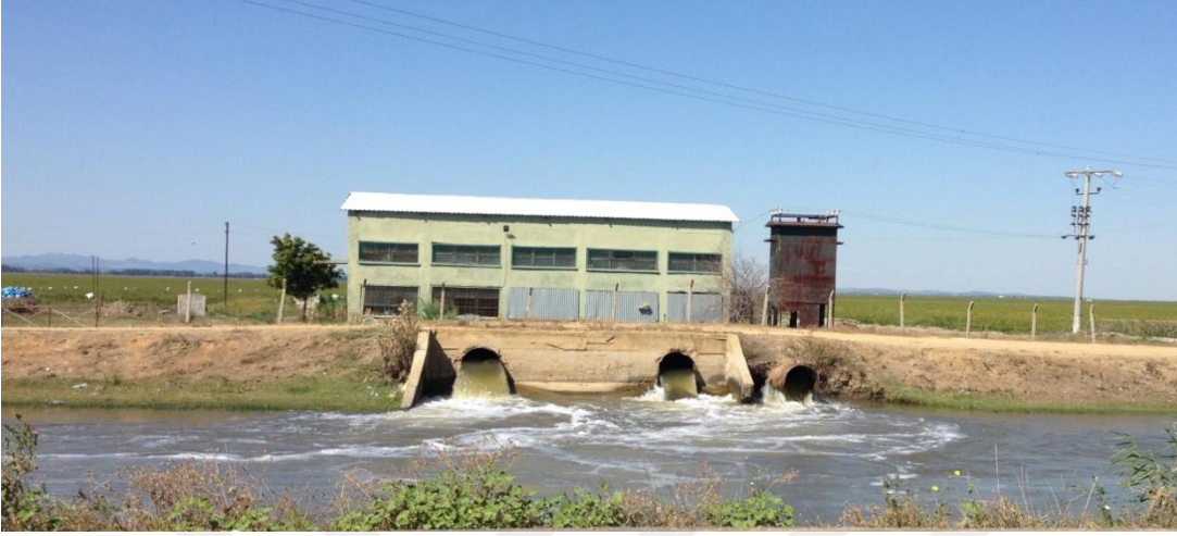
Şekil 4.4 : Cımra pompa istasyonu (24 Ağustos 2017).
