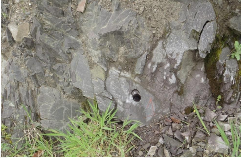
Şekil 3.1.3 : Göçbeyli mevkinde Kurtköy Formasyonu Süreyyapaşa Üyesi örneklemesine ait yüzlek.
