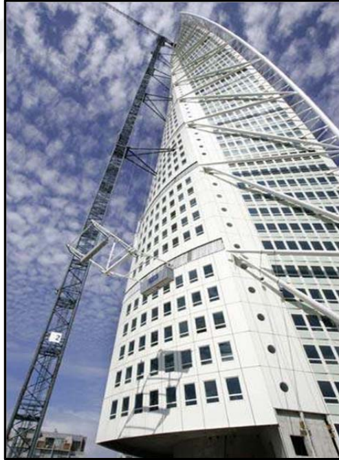
Şekil 3.106. Turning Torso Taşıyıcı Sistemi (Url-35)
