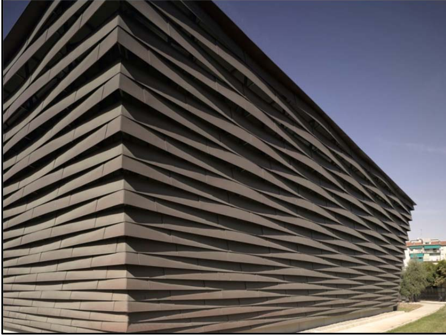
Şekil 3.63. Spor Salonunun Cephe Kaplaması (Url-22)
