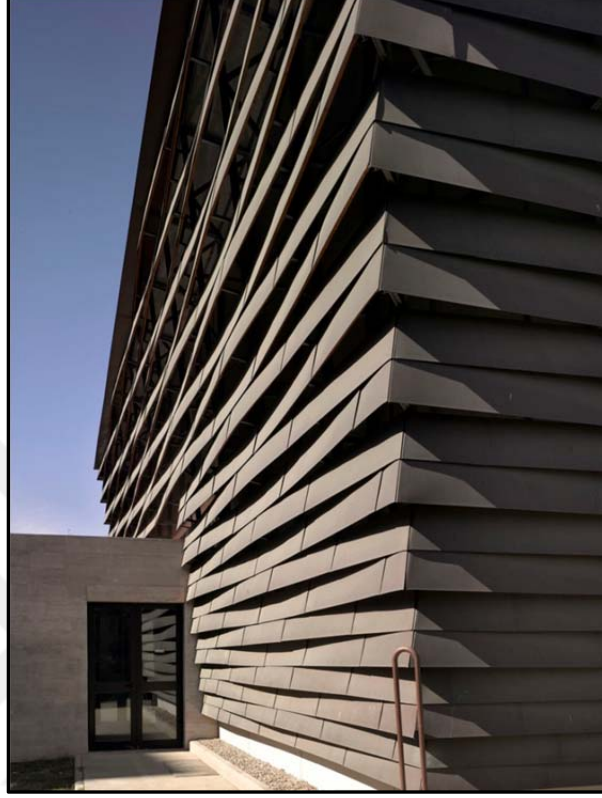
Şekil 3.64. Bakır ile Kaplanan Cephe (Url-22)
