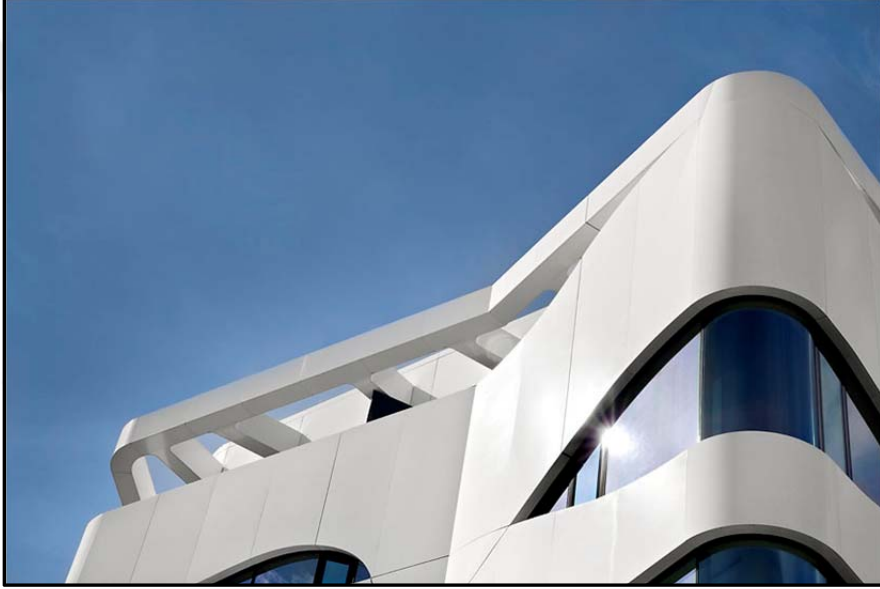
Şekil 3.70. Cephedeki Malzemeler (Url-24)
