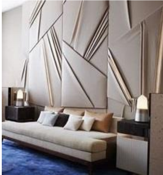
Şekil 36. Kumaş panel uygulaması
