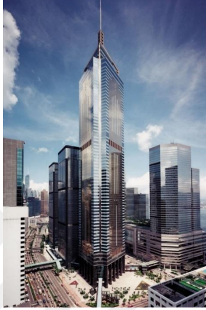
Şekil 7.18. Central Plaza binası (skyscrapercenter.com)
