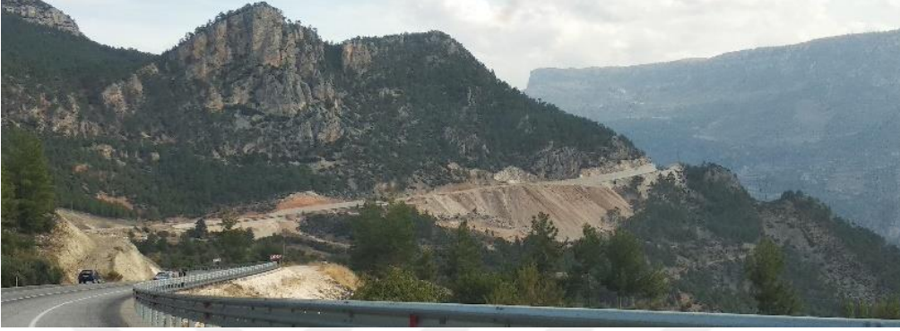
Şekil 4.34. Başyayla ilçesi Güzelyurt mahallesi, Sarıveliler ilçesi Çevrekayak mahallesinde gözlenen heyelanlar.
