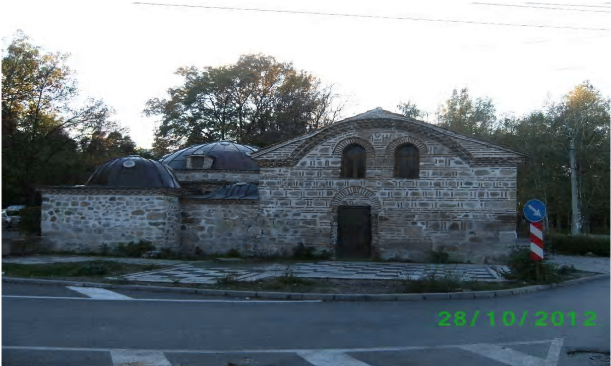
Resim 6/1. Derviş Banya (Hamam) Önden Görünüm 12
