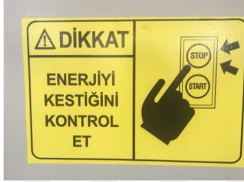
Şekil 5.34. Enerji kesilmeden arızalara müdahale etme
