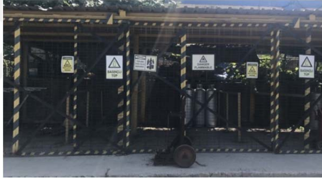
Şekil 5.16. Oksijen ve gaz tüpleri muhafaza alanı
