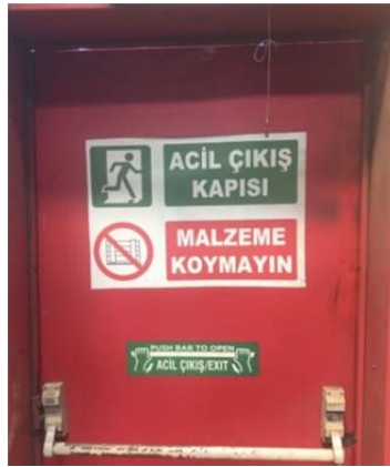
Şekil 5.42. Acil çıkış kapısı uygulaması
