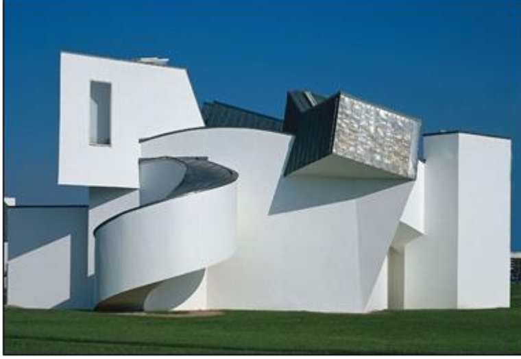
Şekil 6.68. Beyaz alçı sıva ve çinko malzemenin kullanıldığı yapının arka cephesi ( https://www.arkitektuel.com/vitra-tasarim-muzesi/#jp-carousel-6223 )
