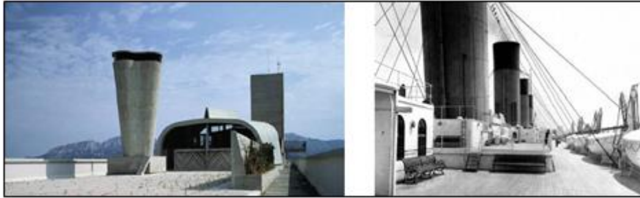
Şekil 6.26. Yapının çatı katındaki havalandırma kuleleri ve geminin bacaları ( https://athome201dotcom.files.wordpress.com/2015/03/unite-dhabitation_englishversion.pdf )
