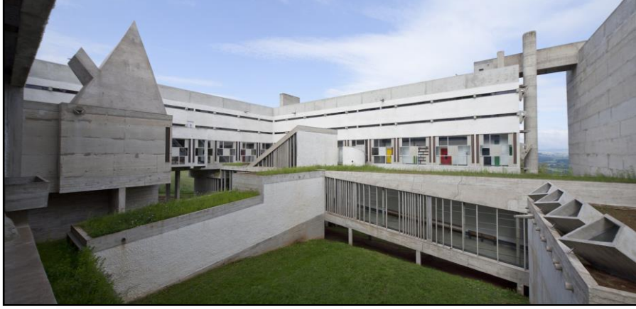
Şekil 6.28. Yapının iç avluya bakan cephesi
