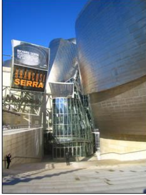
Şekil 6.47. Müzenin güney tarafındaki girişi ( https://www.archdaily.com/422470/ad-classics-the-guggenheim-museum-bilbao-frank-gehry )
