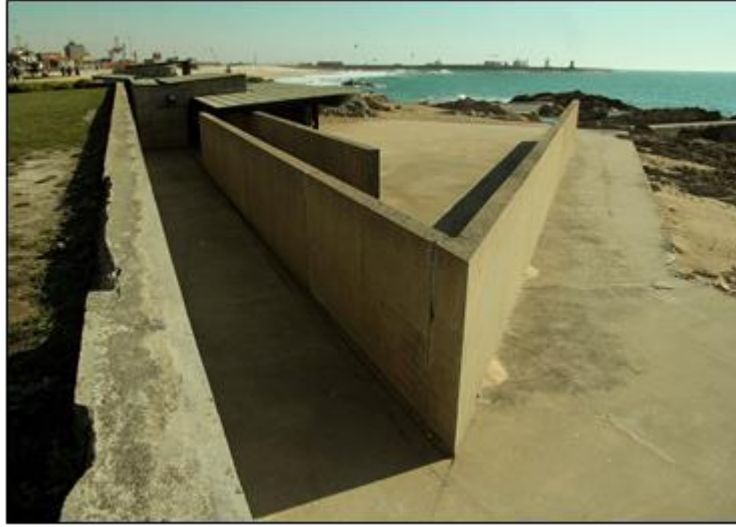
Şekil 6.84. Yapının kuzeyindeki duvar ( https://www.arkitektuel.com/leca-yuzme-havuzlari/ )
