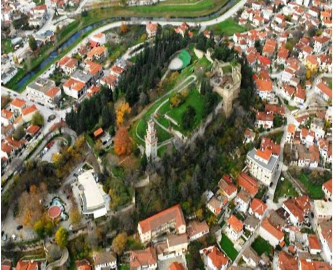
Resim 3. Tırhala Kalesi Kuşbakışı Görünüm 3
