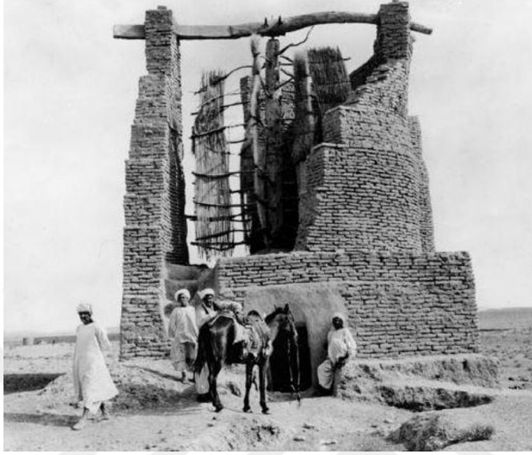
Şekil 3.11. Dikey eksenli rüzgar gülü ve yel değirmeni
