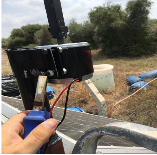
Şekil 3.29. Motorun panel üzerindeki profile sabitleme montajı
