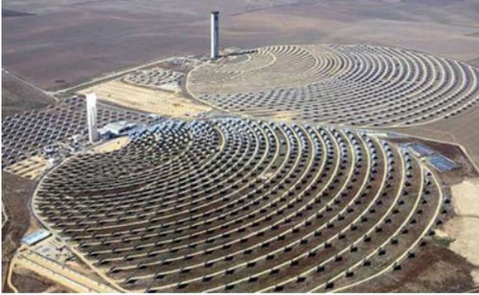
Şekil 3.8. İspanya Sevilla PS20 Merkezi alıcılı güneş enerji sistemi
