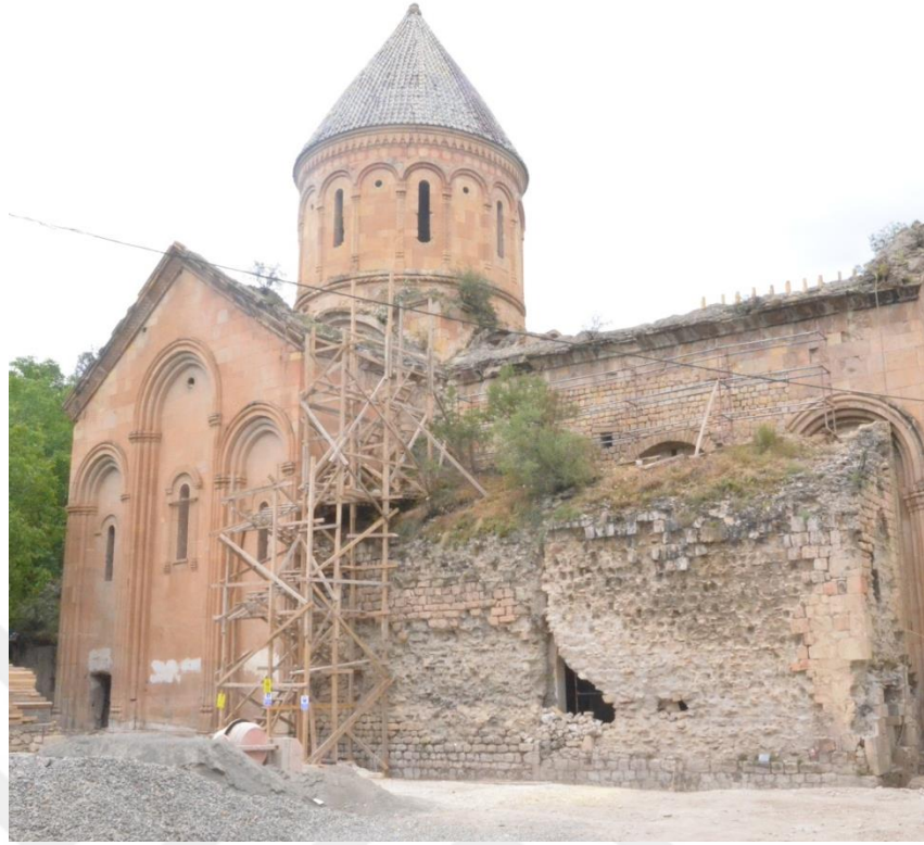
Resim 79: İşhan Kilisesi Restorasyonu, Malzeme ayrıntısı (G.Tiryaki, 2017)
