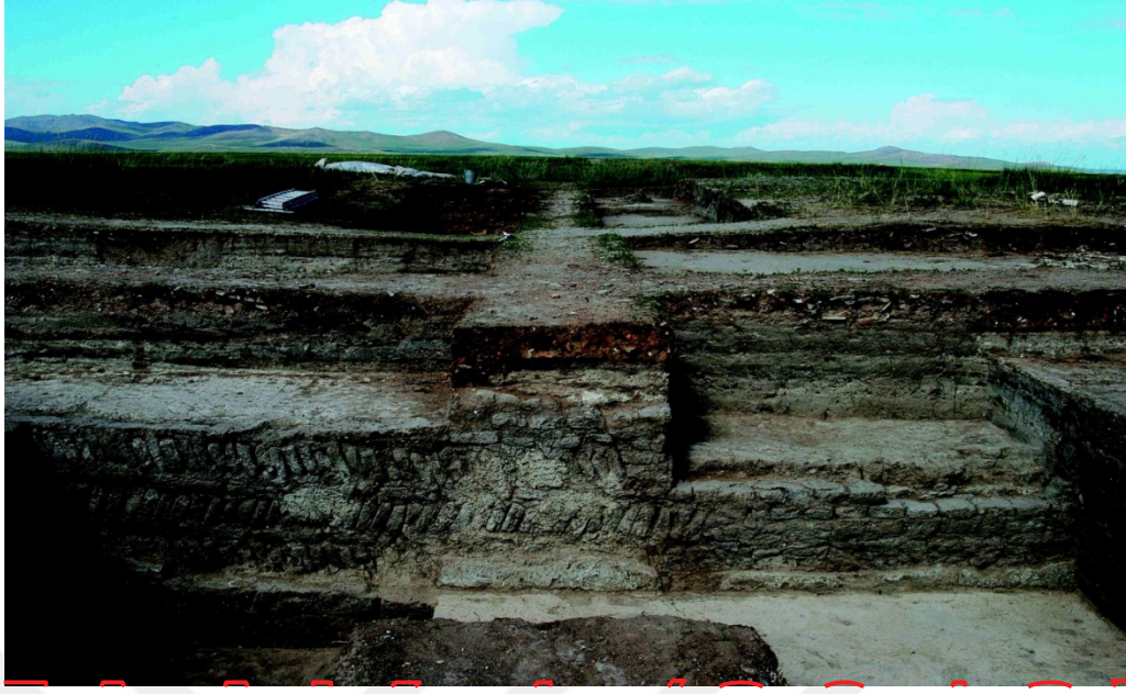
Resim 43. HB1 alanında 2010 yılında yapılan kazılarda görülen balık sırtı duvar örgüsü (Hüttel ve Dähne, 2012:426).
