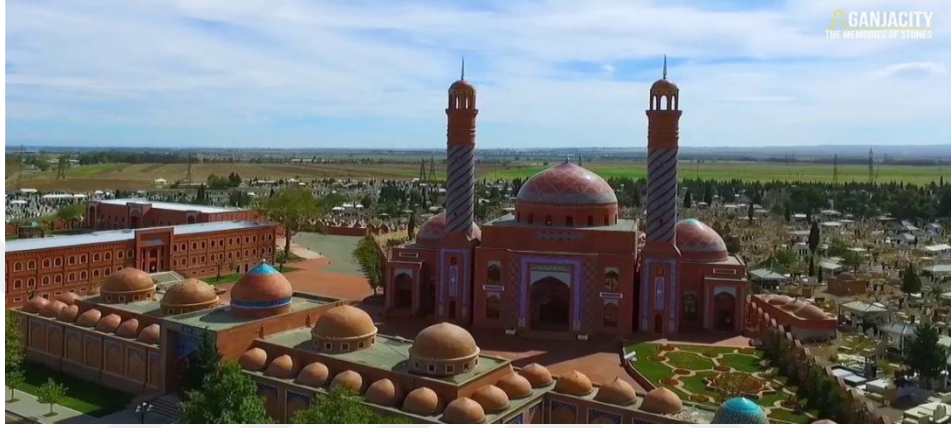
Resim 7: Gence İmamzade Türbesi Kaynak: ganjanews.az
