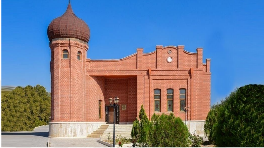
Resim 25: Zaviye Medrese Binası
